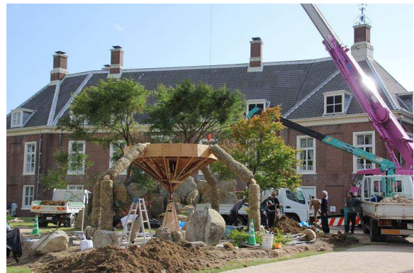
【25日 施工の様子】
